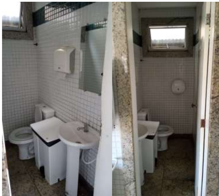
Figura 19: Banheiro Recepção Pronto Socorro Feminino-HABF
