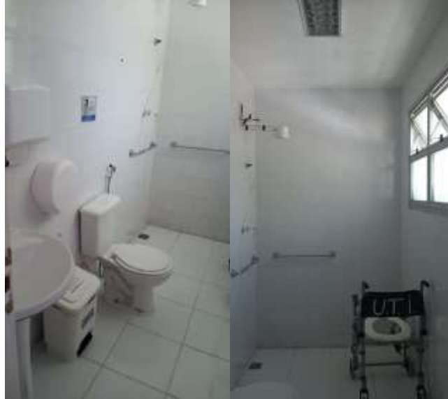
Figura 34: Imagens banheiro da UTI - HABF
