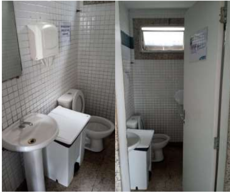
Figura 20: Banheiro Recepção Pronto Socorro masculino - HABF
