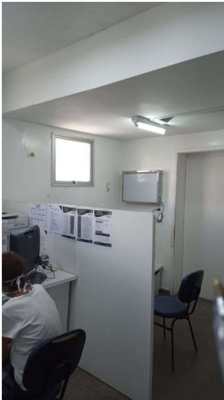
Figura 2: Divisórias das salas de ortopedia 01 e 02 do HABF
