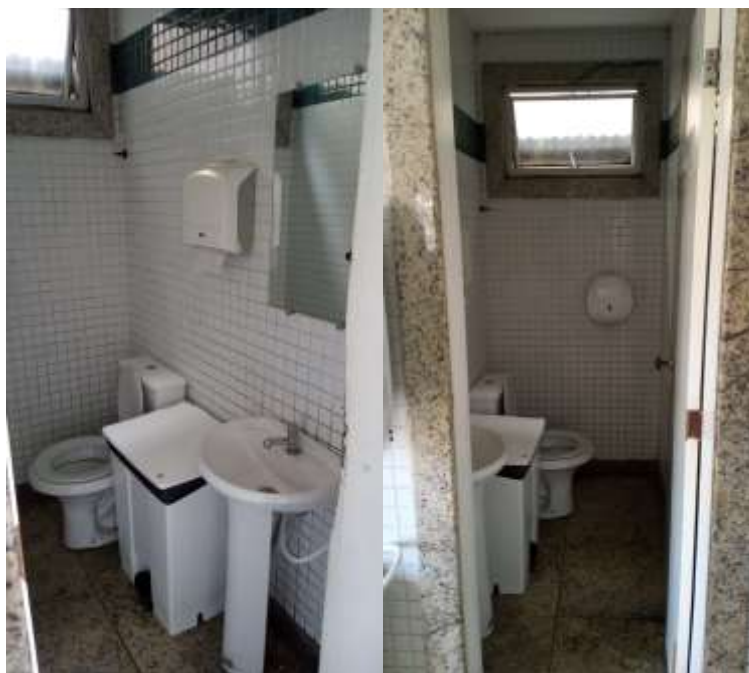
Figura 19: Banheiro Recepção Pronto Socorro Feminino-HABF
