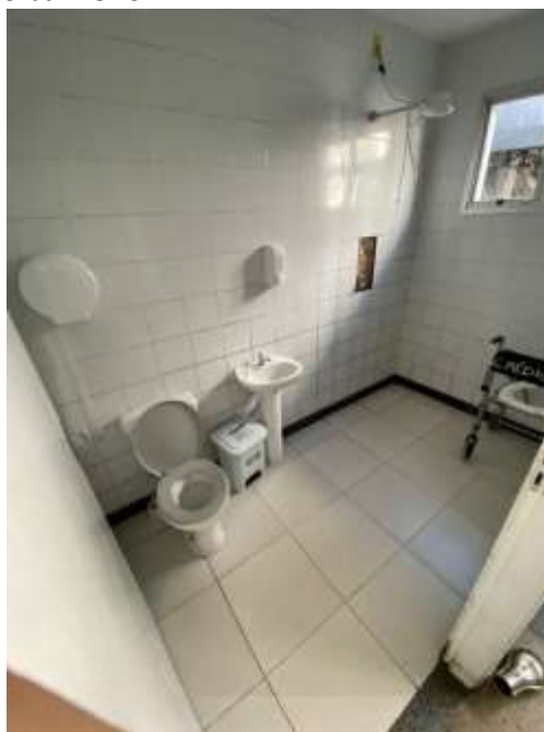
Figura 56: Imagem atual do banheiro enfermaria 13 – HABF
