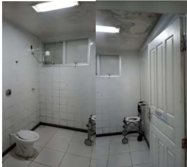
Figura 28: Banheiro da Estabilização - HABF
