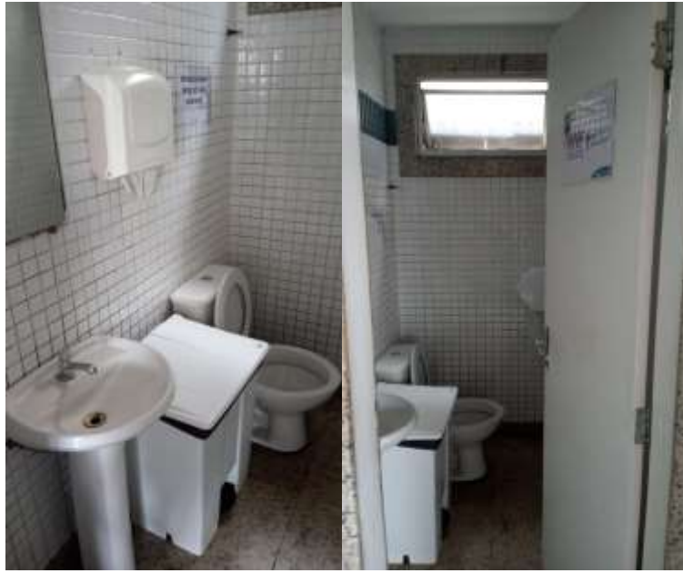
Figura 20: Banheiro Recepção Pronto Socorro masculino - HABF
