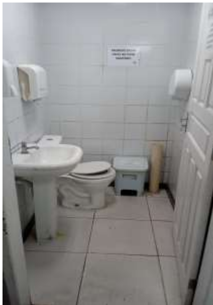
Figura 17: Imagem banheiro Posto de Enfermagem –HABF
