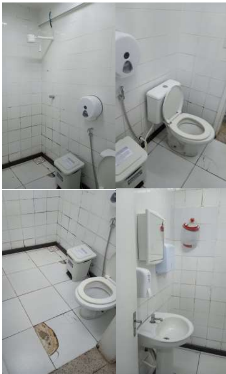
Figura 22: Imagens do banheiro da Emergência - HABF
