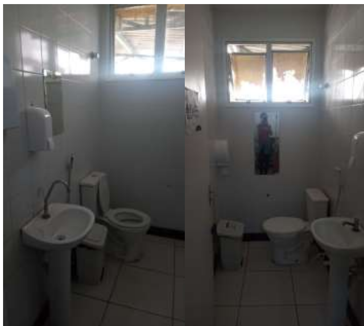
Figura 29: Imagens Banheiro do Laboratório – HABF
