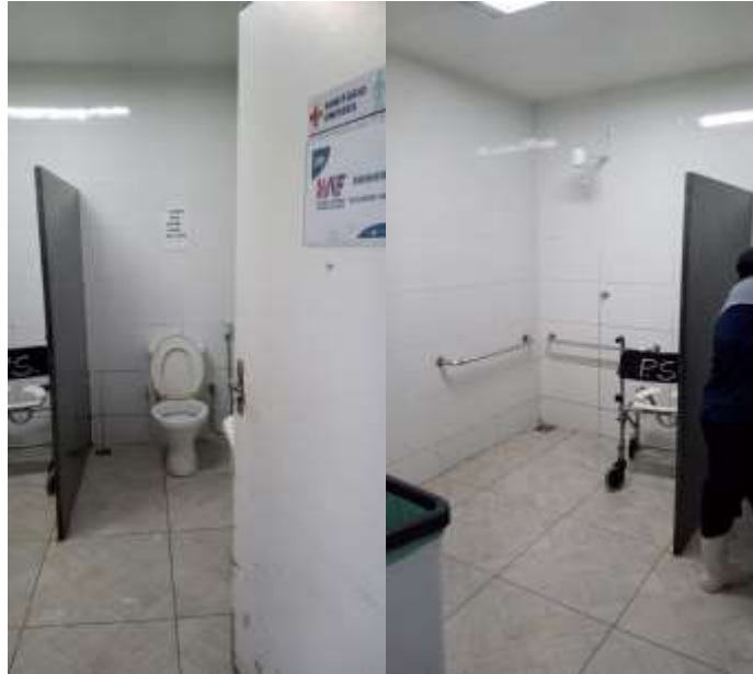
Figura 15: Imagens do banheiro do Posto de Enfermagem - HABF
