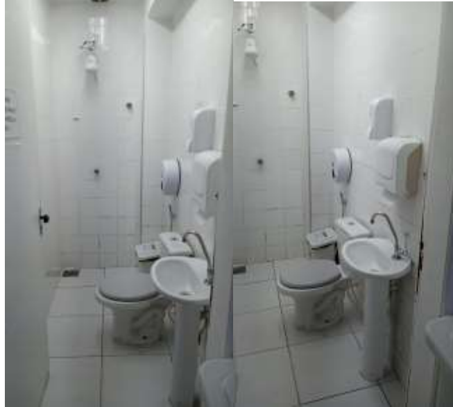
Figura 24: Imagens banheiro da UTI III
