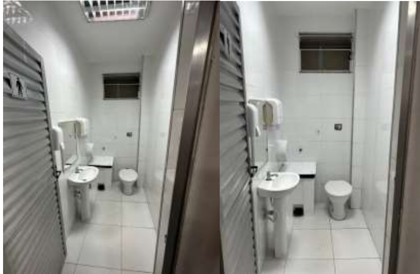
Figura 13: Imagem do banheiro da Recepção Social-HABF
