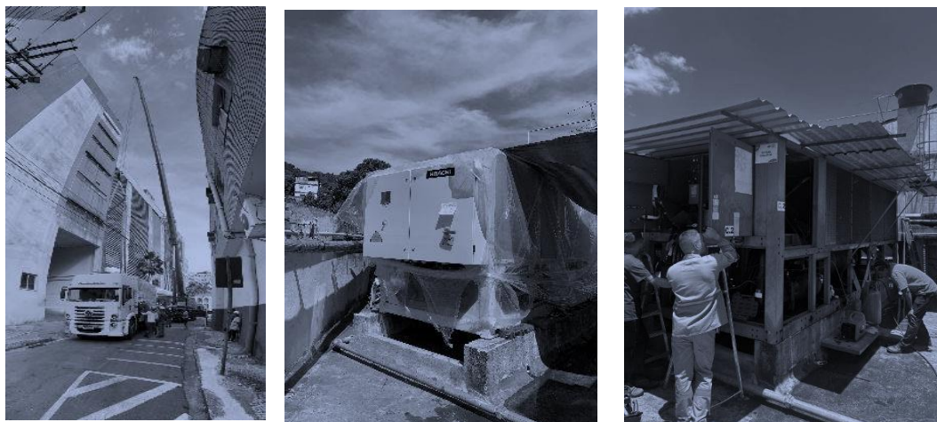
(Figuras 34, 35 e 36 – Instalação de chiller no HEC)
