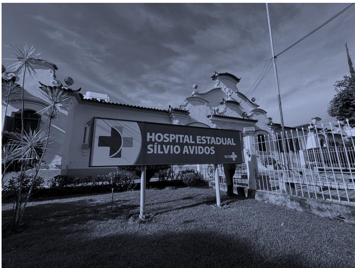
(Figura 75 – Fachada do Hospital Estadual Silvio Avidos)
