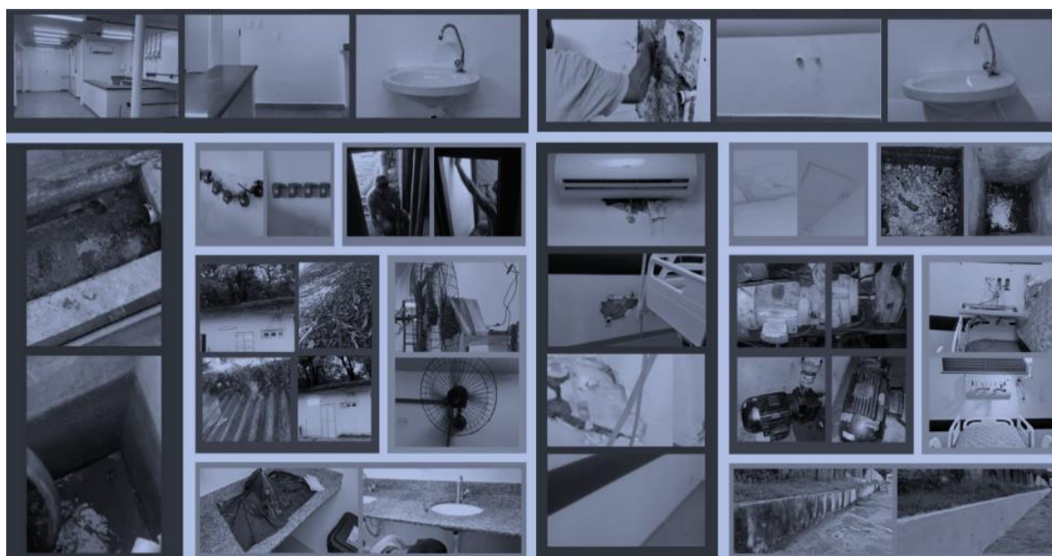
(Figuras 43 e 44 – Melhorias estruturais no HDDS)
