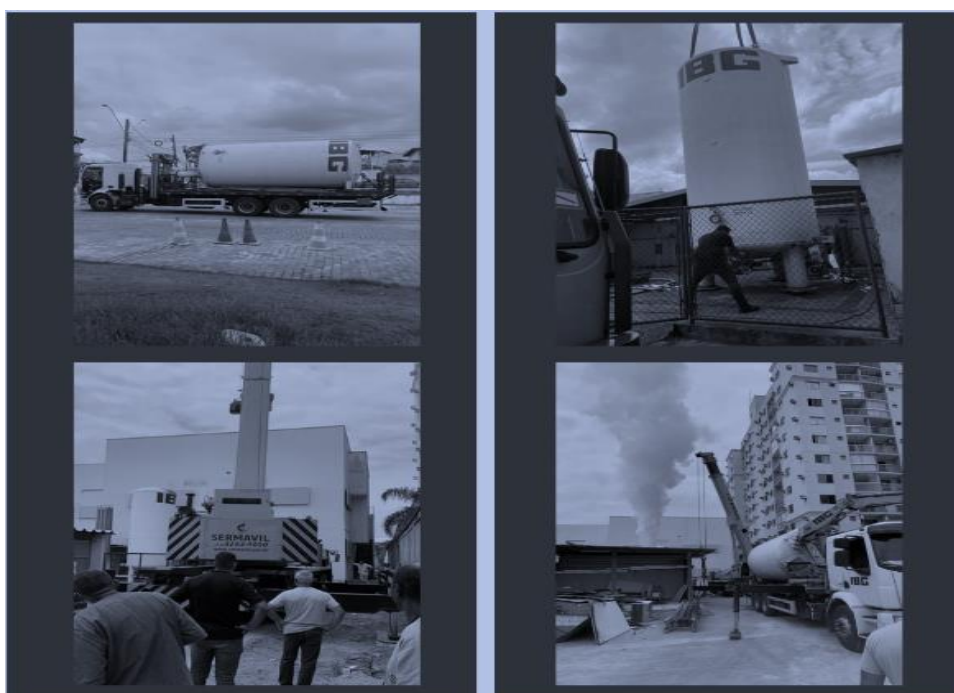
(Figuras 39, 40, 41 e 42 – Substituição do tanque de oxigênio no HDDS)
