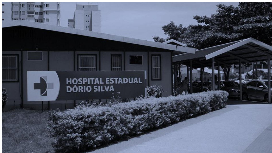
(Figura 70 – Fachada do Hospital Doutor Dório Silva - HDDS)
