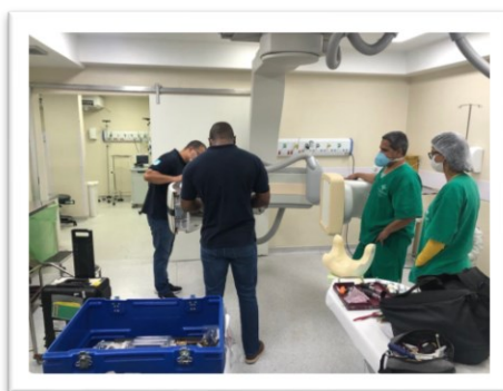
(Figura 22: Manutenção com troca do tubo da Hemodinâmica no HEC)
