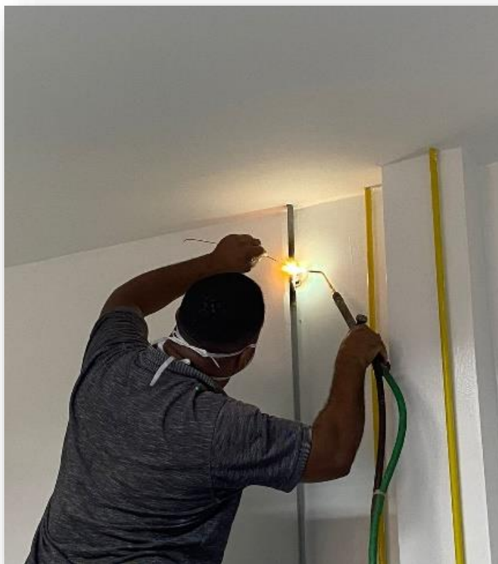
(Figura 12 – Manutenção rede de vácuo UTI I no HABF)
